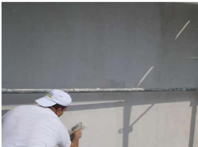
Il est important, avant d'appliquer la finition, de contrôler le support une fois sec et de supprimer les aspérités ou sardines pour obtenir une surface parfaitement lisse pouvant recevoir une finition mince.
